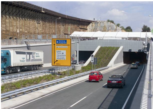
Quelle: Herrentunnel Lübeck GmbH & Co. KG
